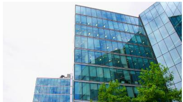
Große Glasfassaden, sich darin spiegelnde Gebäude und Bäume sind typische Gefahrenstellen (Foto: P. Bria).
